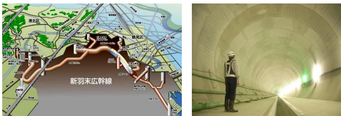
図 3-16 下水道管内の様子（新羽末広幹線） 28
