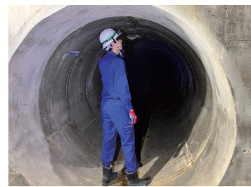
完成した下水道管確認時の様子
