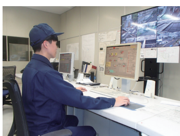
中央操作室での作業時の様子
