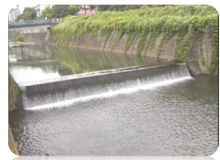
改良前の落差工 (NO.2 用賀下橋下流)
