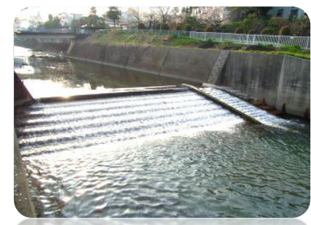
改良後の落差工 (NO.2 用賀下橋下流)
