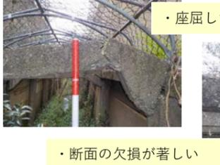
座屈している<br>
