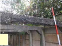
断面の欠損が著しい         |
