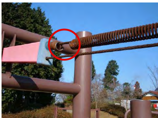
▲ 緩衝部（スプリング）の破損
