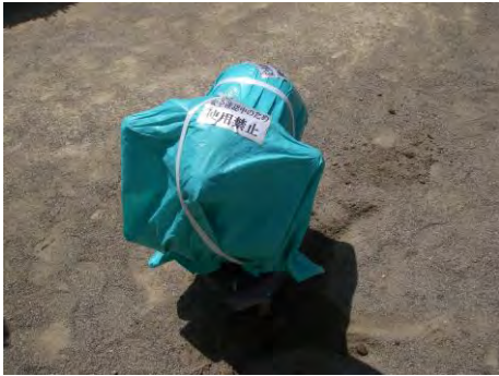
▲ 本格的な使用禁止措置の事例 【小型施設（スプリング遊具）の事例】
