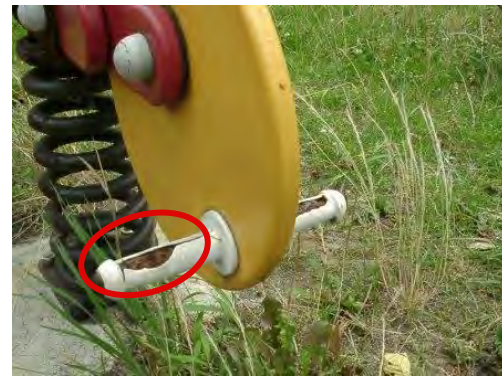
▲ 足掛部の損傷
