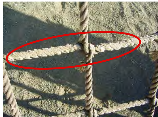
▲ ネットの破損・摩耗
