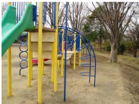
▲ 部分的な使用禁止措置の事例
