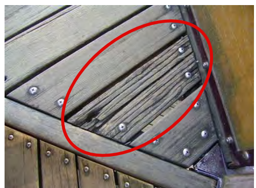
▲ 床材の腐朽
