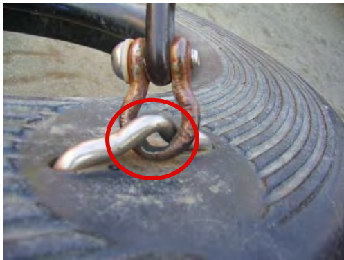
▲ 取付金具の摩耗
