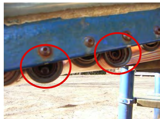
▲ ローラーすべり台のローラー破損
