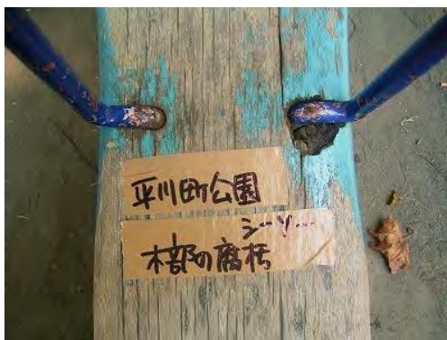
▲ 板の腐朽、取っ手のぐらつき
