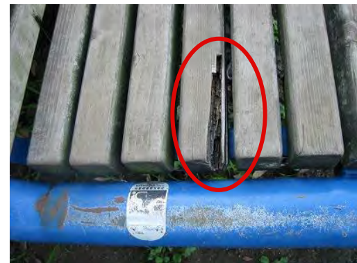
▲ 座板の腐食
