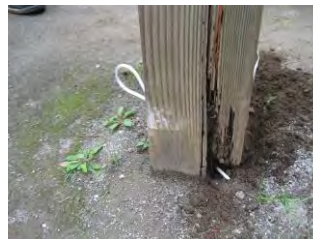
腐朽の最終段階
