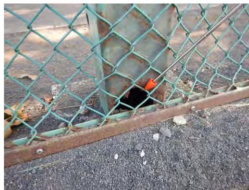
▲ 高尺フェンス 支柱穴
