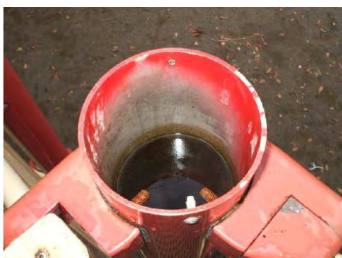
▲ 柱頂部キャップ欠落
