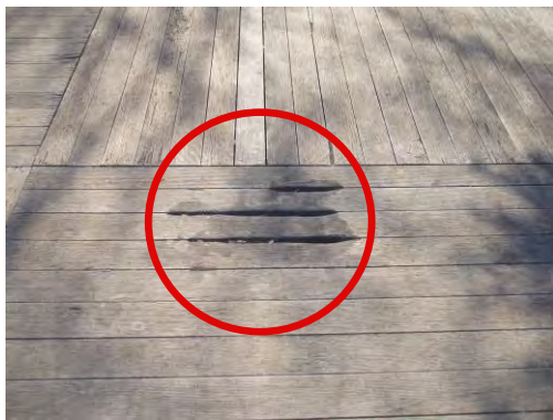
▲ 木製デッキ 床面破損（たき火あと）
