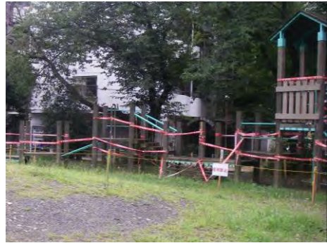
▲ 応急的な使用禁止措置の事例 【木柵＋使用禁止テープ】
