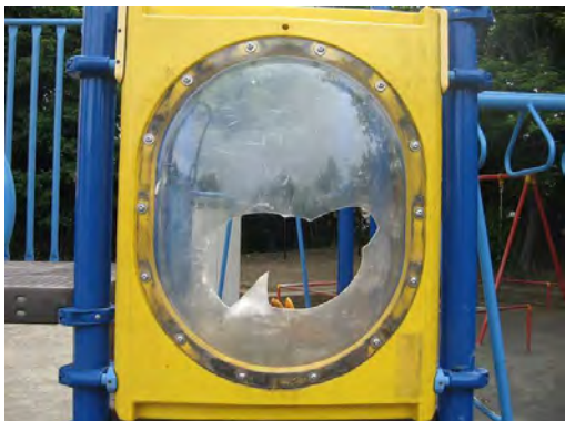
▲ ドームパネル破損
