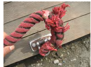
ロープ類の劣化状況
