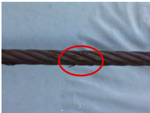
▲ ケーブルの摩耗（素線破断）
