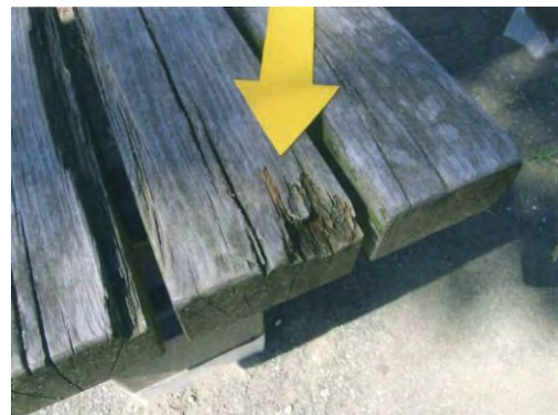
▲ 木製ベンチの腐食
