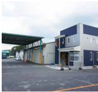
高効率な空調設備を導入した倉庫
