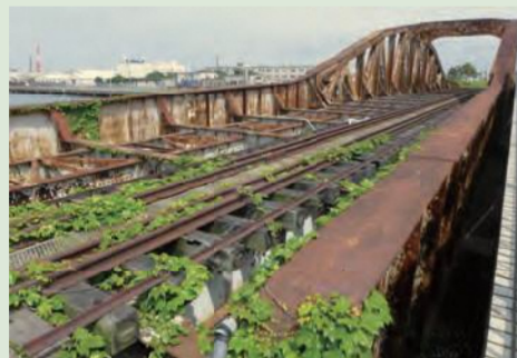
陸側から見た全景。美しい橋梁だ
