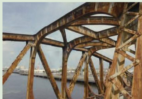
珍しい溶接とリベットの接合部分
