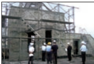
改修工事中の横浜地方気象台庁舎
