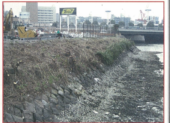
谷積の傾斜した護岸
