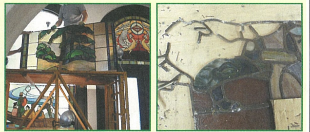
4枚で繋がれているステンドグラスを上 ガラスと鉛棧を分解部から取り外す
