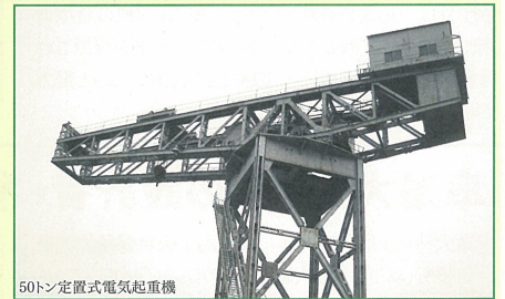
50トン定置式電気起重機
