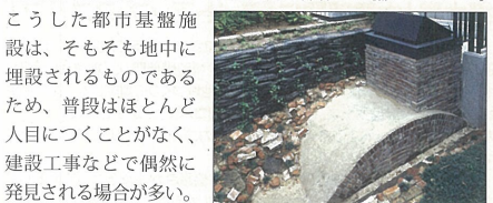
④旧居留地消防隊地下貯水槽 資料:横浜市発展記念館
