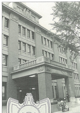
復元された正面玄関と柱頭飾り
