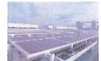
太陽光発電システム
