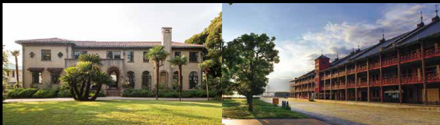
かつての外国人住居が集中する山手エリアでも最大級の規模を誇る洋館である、ベーリック・ホール
