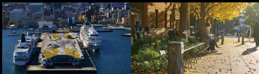
国際公開設計コンペを経てデザインされた、大さん橋国際客船ターミナル 歴史的建造物や銀杏並木に調和し、腰もかけられる日本大通りの植栽防護柵
