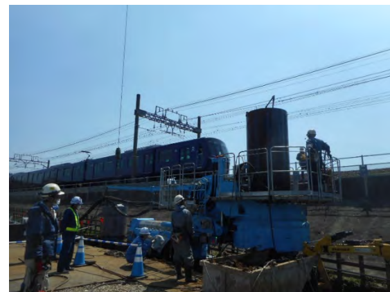
鋼管杭圧入状況
