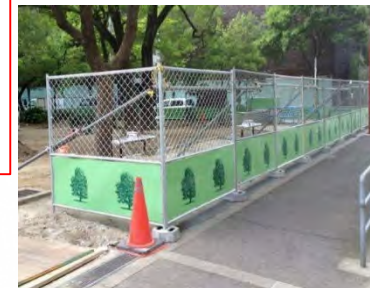
フェンスの設置 (イメージ)
