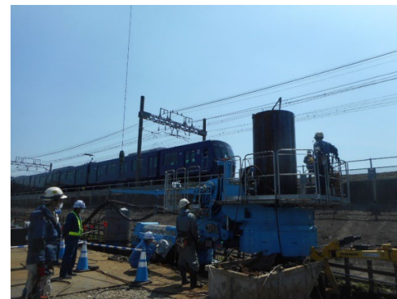
鋼管杭圧入状況
