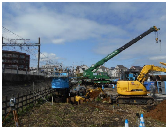
鋼管杭圧入工事
