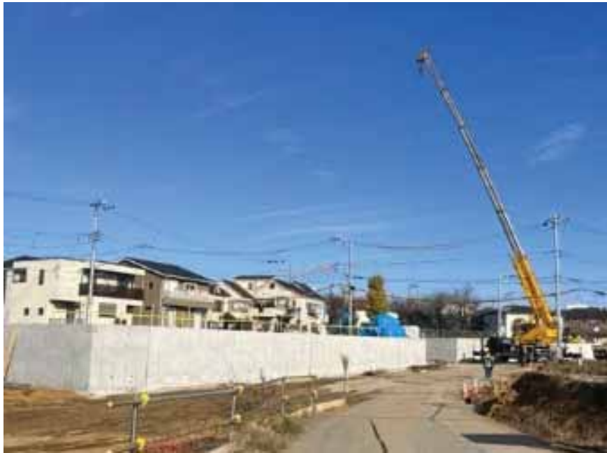
↑ 仮換地先となる宅地の擁壁設置工事を行っています。
