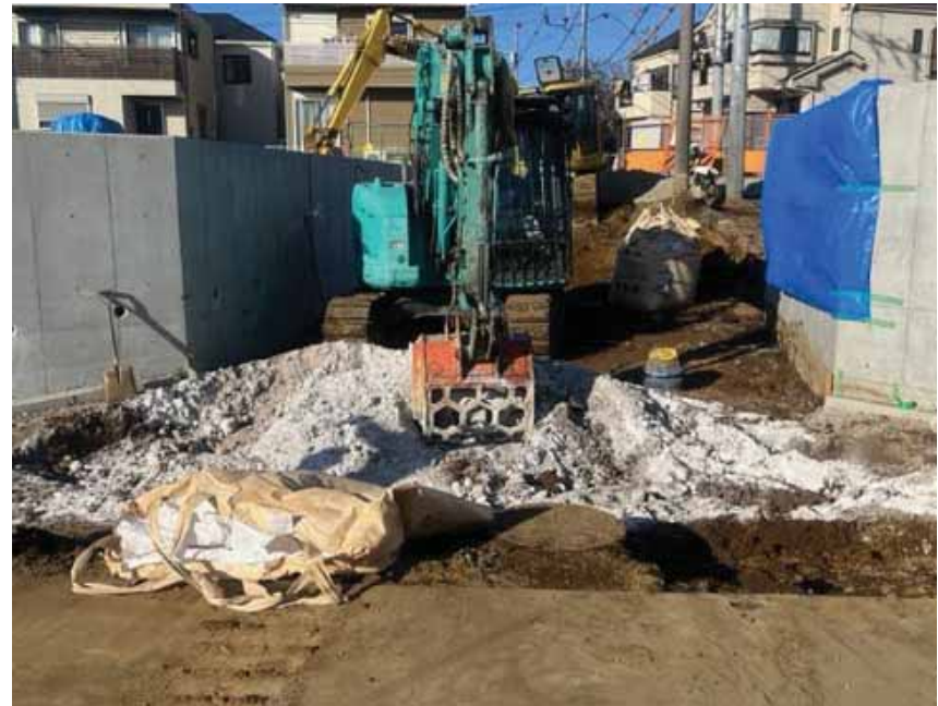
↑ 路床 (※) 改良工事を行っています。 (※) 道路を走行する車体の重みを支える層
