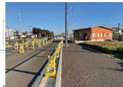
三ツ境下草柳線（整備済み箇所）
