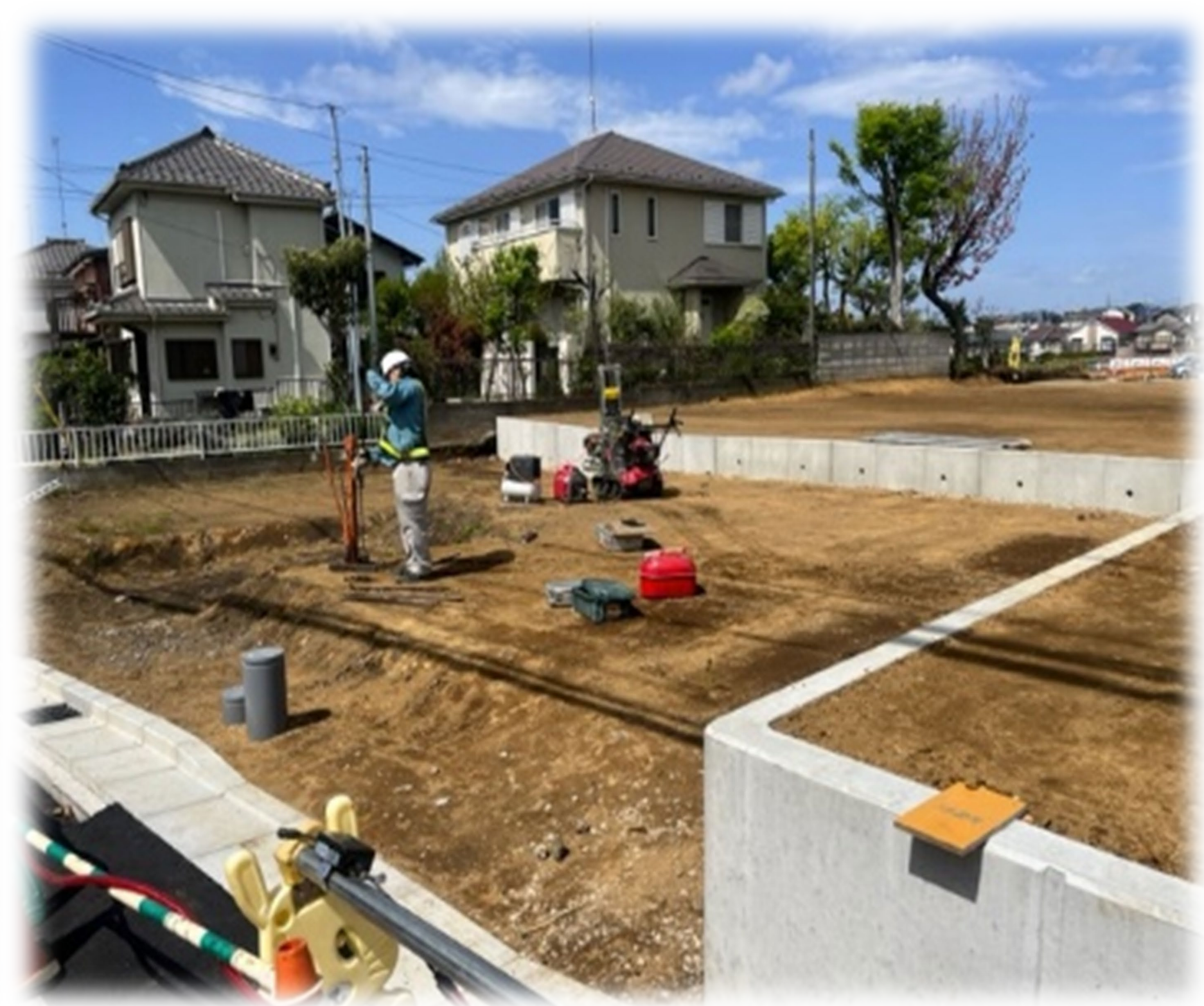
造成中の宅地
