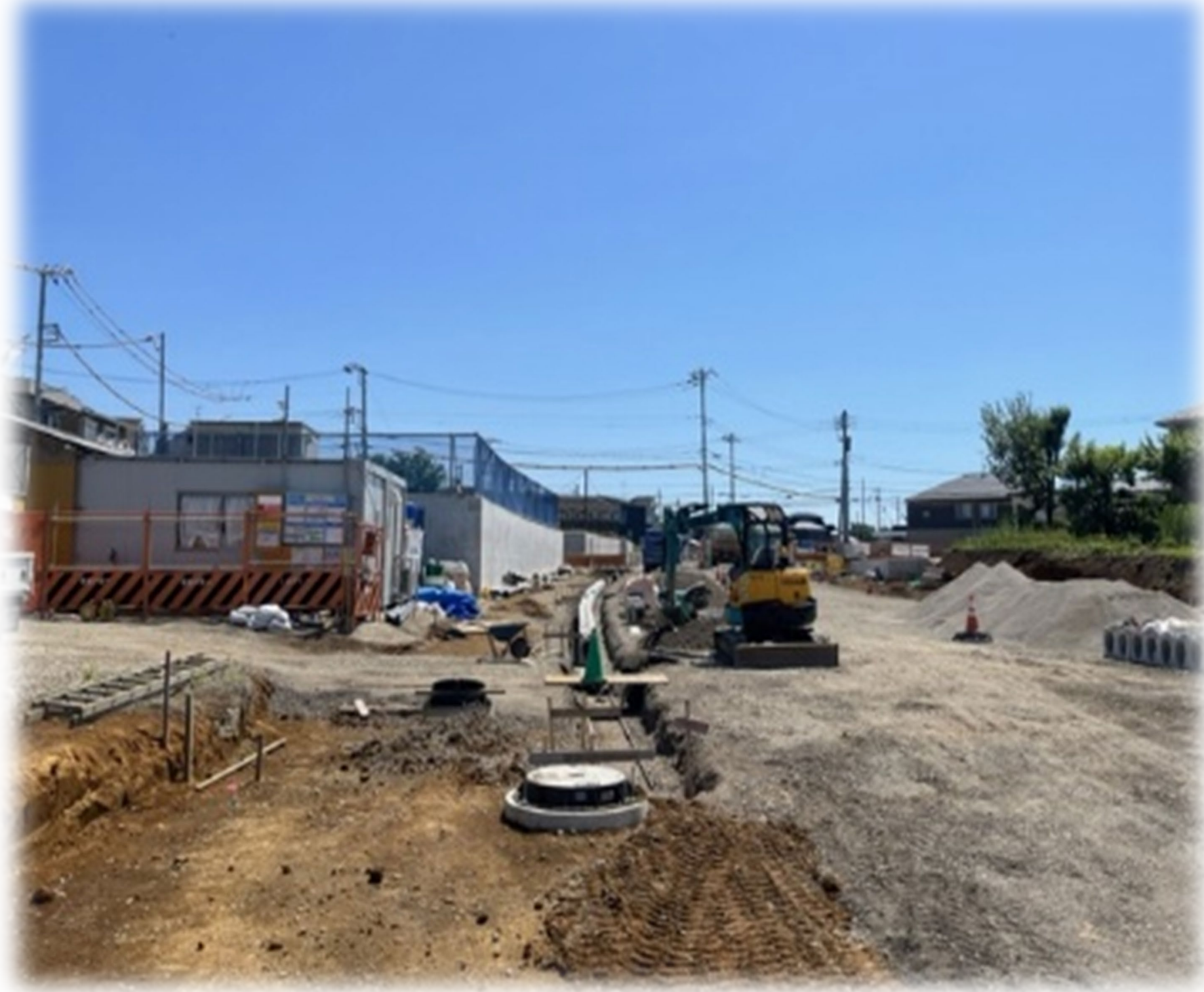
都市計画道路 工事状況
