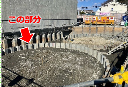
躯体(鋼矢板)の工事完了後の様子
