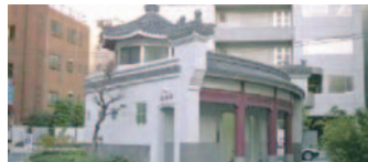
3 洗手亭(山下町(中華街)公衆トイレ)(中区)
