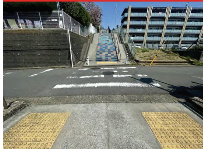
⑤ 100段階段と車道が交差する地点 飛び出し抑制注意喚起タイル設置予定
