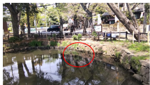
排水口の整備(水位調整を容易にする)
