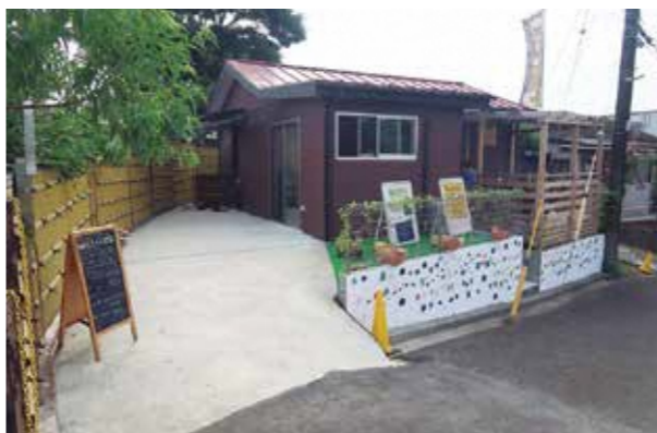
車椅子でもアプローチできるように滑らかな傾斜に。屋外の壁面のタイルは利用者と共に制作したもの
