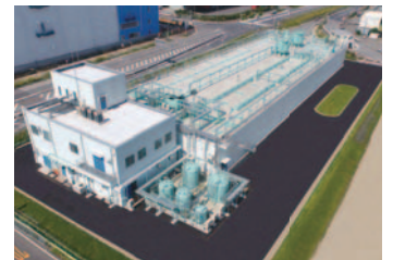
南本牧第5ブロック排水処理施設
