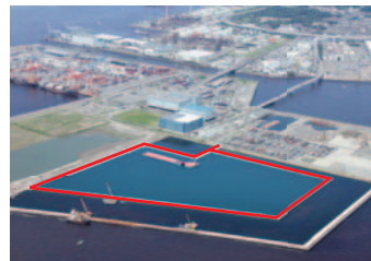
南本牧第5ブロック廃棄物最終処分場
