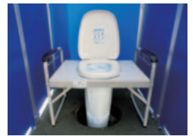
下水直結式仮設トイレ
