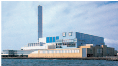
金沢工場(2001年4月稼働)
