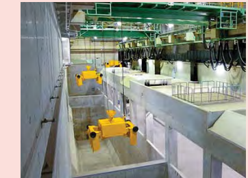
灰ピット / 灰クレーン Ash pit & Ash crane
