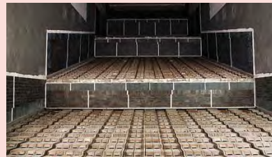
焼却炉内部 Stoker
