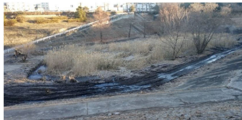
遊水池の現況写真（令和7年1月15日撮影）
