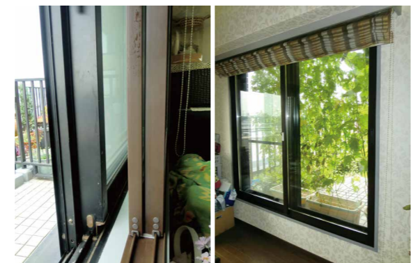
●内装をいじることなく既存木製枠を利用して取り付けられた内窓。
