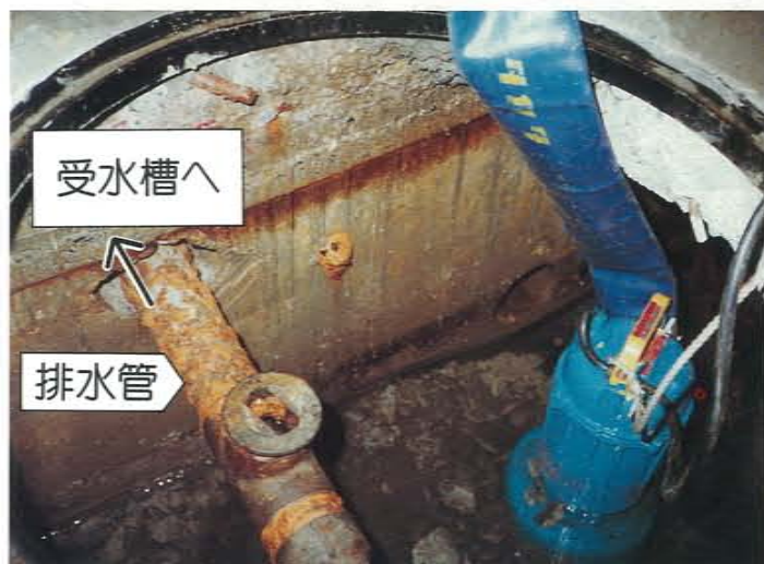
㊸側から見たところ
