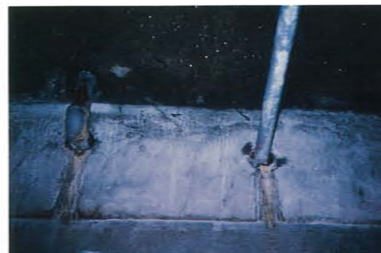
㊸側から見たところ
