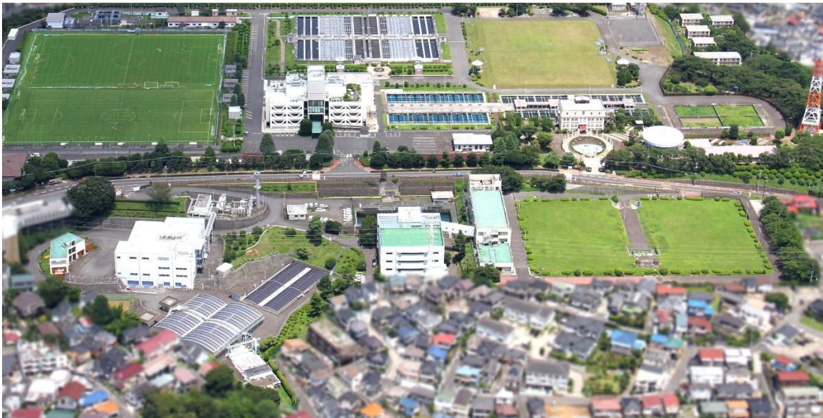
令和4年度から再整備事業が本格化した西谷浄水場
