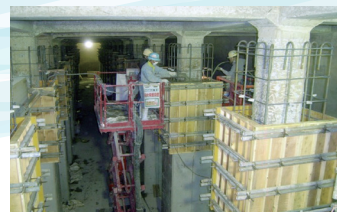
▲配水池の耐震化工事
