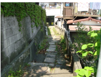
三春台防災まちづくり（整備前）
