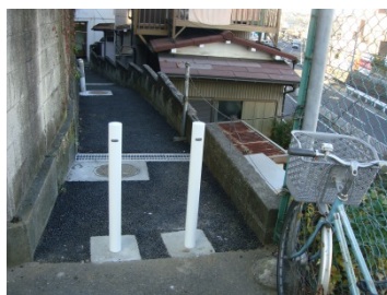
三春台防災まちづくり（整備後）
