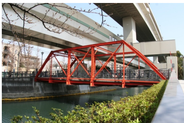
震災復興橋である浦舟水道橋（登録歴史的建造物）
