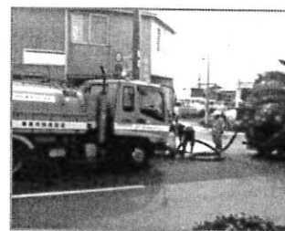
平成25年10月16日 伊豆大島三原山土石流災害
