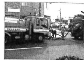
平成 25 年 10 月 16 日 伊豆大島三原山土石流災害
