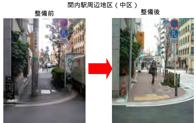
歩道の段差解消、電柱撤去、視覚障害者誘導用ブロック設置等
