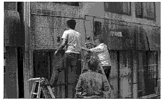
小規模店舗日除け型看板撤去 (初黄・日ノ出町地区)
