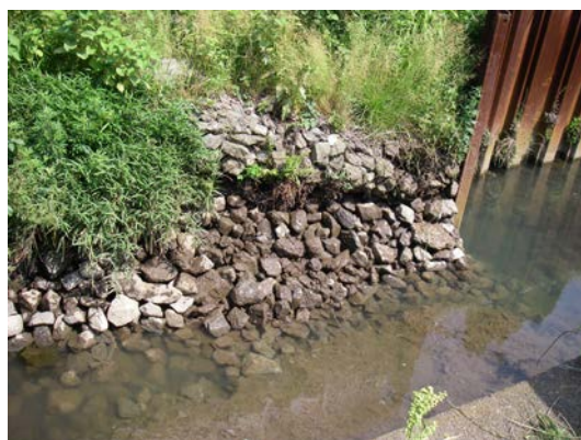
応急対応実施後 (石投入)
