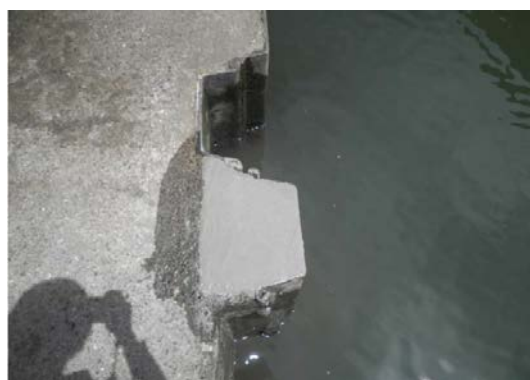
応急対応実施後 (根継ぎ矢板背面をコンクリート充填済み)
