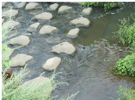
障害物除去後
