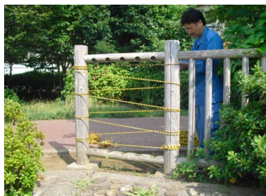
応急対応実施後 (縦格子対応予定)
