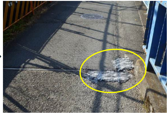
応急対策実施後
