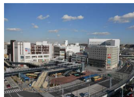
再開発後の戸塚駅西口第 1 地区 第 1 交通広場側からの撮影
