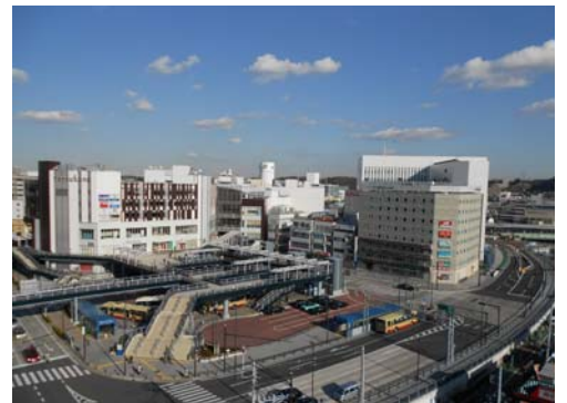
再開後の戸塚駅西口第 1 地区 第 1 交通広場側から撮影
