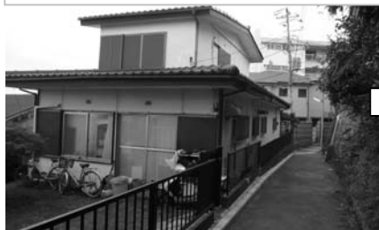
老朽建築物の除却 (南区唐沢・平楽・八幡町)
