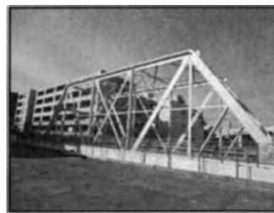
架替え工事の様子 (霞橋：中区)
