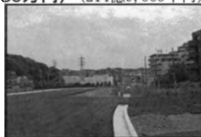
幹線道路の整備(下永谷大船線)
