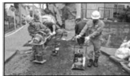
道路の維持・管理(舗装補修)
