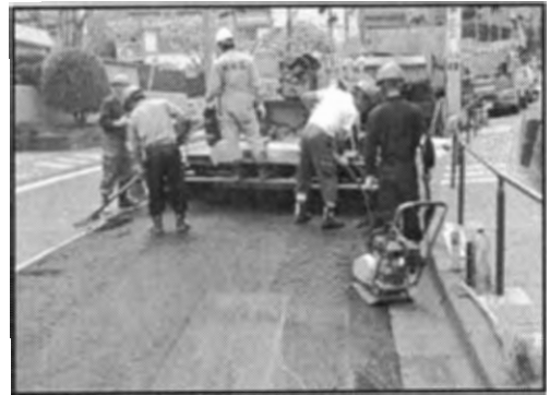
道路の維持・管理（舗装補修）
