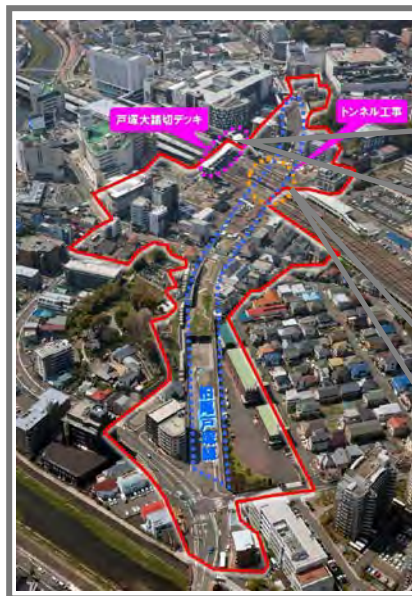
戸塚駅前地区中央 土地区画整理事業（施行中）
