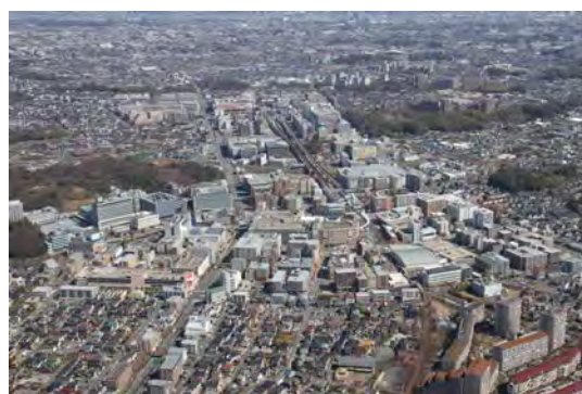
<港北ニュータウン地区>
