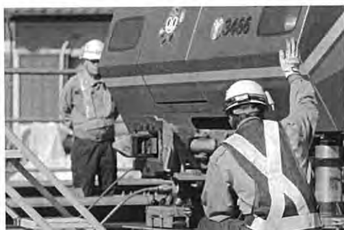
【脱線車両復旧作業（異常時総合訓練）】
