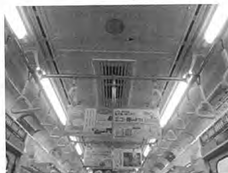
【LED化した地下鉄車内の照明】
