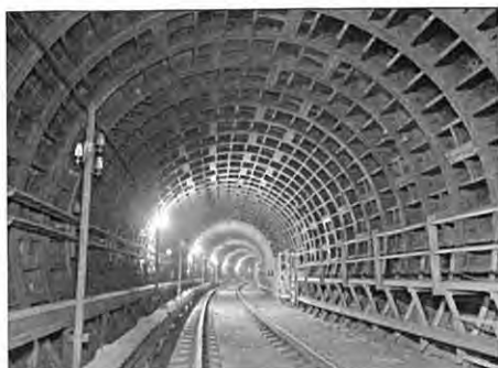
【平沼町シールドトンネル】
