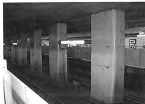
【中柱を補強した開削トンネル】
