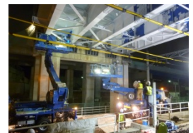
橋梁の補修工事
