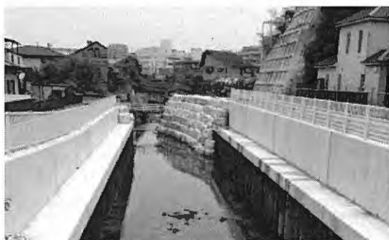
今井川(元町橋下流の護岸改修状況)
