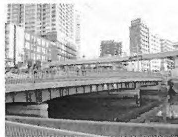
耐震補強を行う万里橋 (西区)
