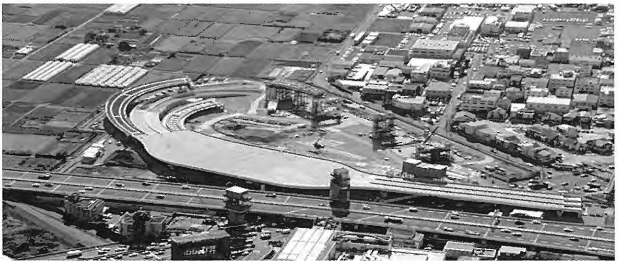
横浜環状北線 港北ジャンクション部 (橋脚工、上部工架設を実施中)
