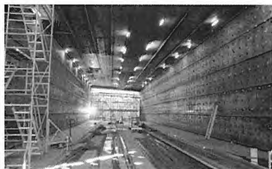
今井川(JR岩間川橋梁工事の施行状況)
