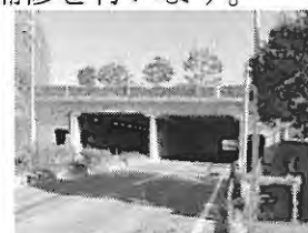
補修を行う矢指隧道 (旭区)
