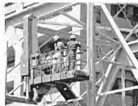
橋梁点検の様子 (霞橋:中区)
