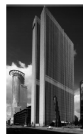
フランクフルト事務所入居ビル
