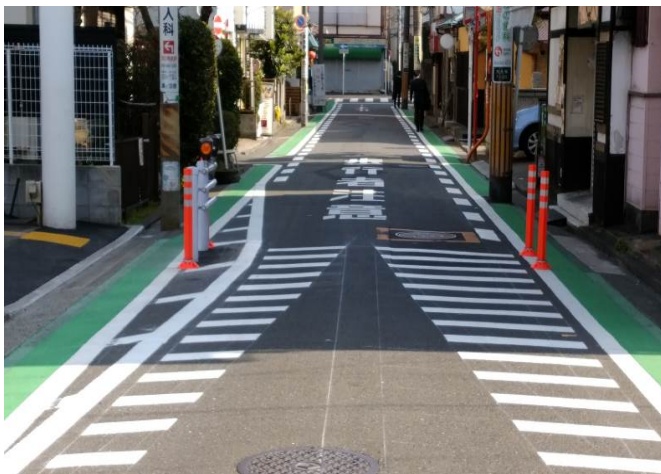
写真 1. 狭さく状に部分的なガードパイプ設置 (事故現場の道路で 2 か所に設置)
