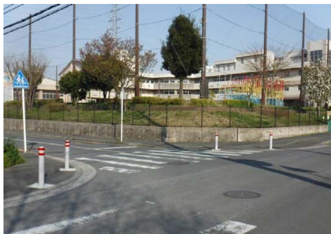
写真3. 再点検による新たな要望への対応 交差点歩道部へ車止めの設置(都筑区:東山田小)
