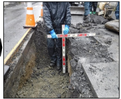
<開削・補修中写真>
