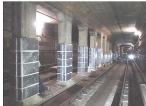
柱下部から組み立てて、柱全体の巻き立てを完成します。
