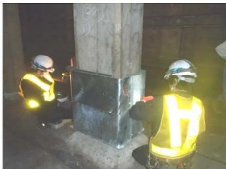
柱の周囲に小型に分割した鋼板を組み立ててモルタルを注入し、柱と鋼板を一体化させます。
