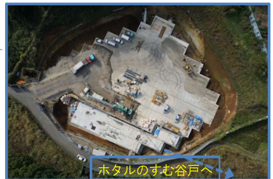
雨水調整池（築造中にドローンにて撮影）
