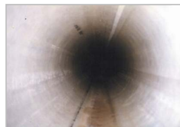
管更生による施工
