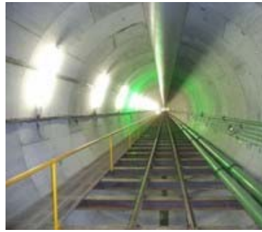
雨水幹線の整備
