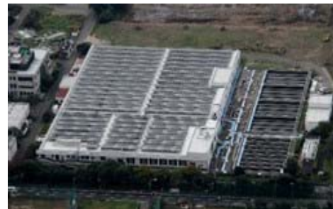
太陽光パネルの設置(西部水再生センター)
