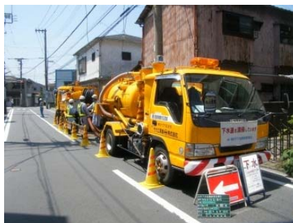
吸引車による下水道管の清掃
