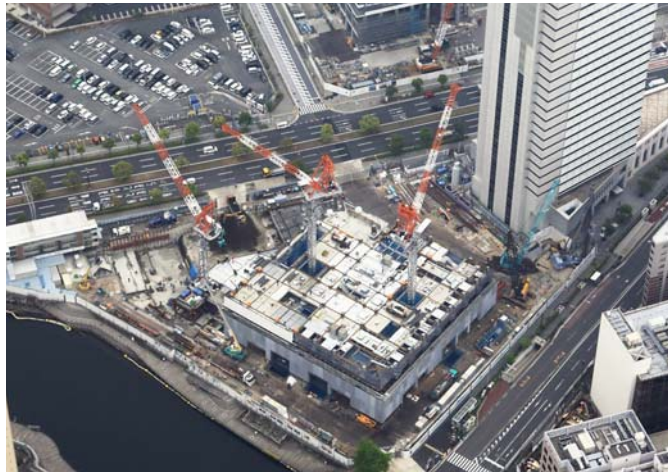
[桜木町駅方面 上空からの様子 (H30.4月)]
