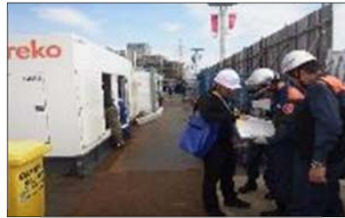
仮設発電設備の事前確認
