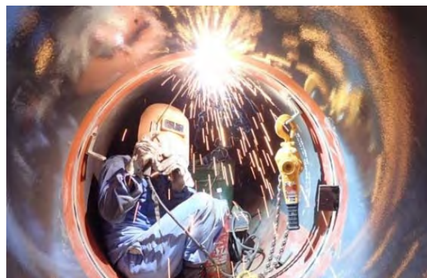
【老朽管耐震更新工事（管内溶接）】
