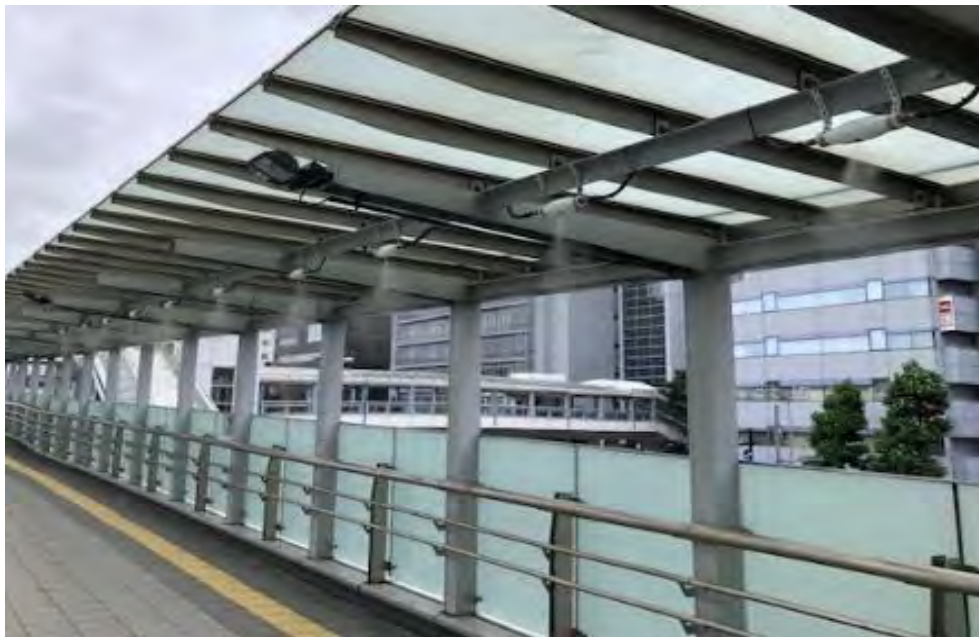
ミスト装置の設置風景（新横浜駅前）
