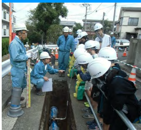
工事現場見学会
