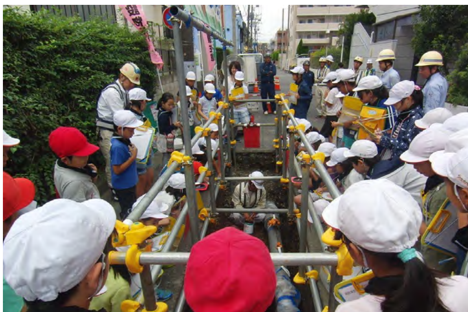
工事現場見学会
