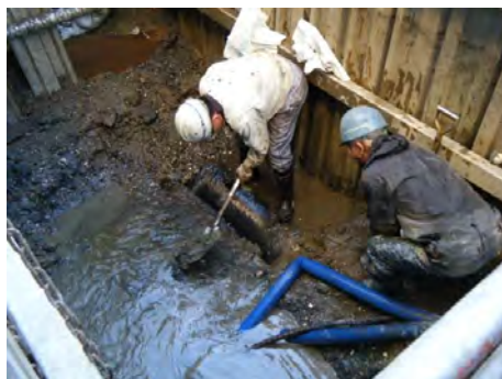
請負事業者による緊急漏水修理の様子
