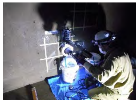
配水池の健全度調査の作業状況
