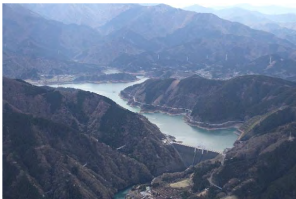
宮ヶ瀬ダム (平成 13 年完成)
