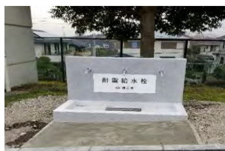
青葉区鴨志田緑小学校の耐震給水栓
