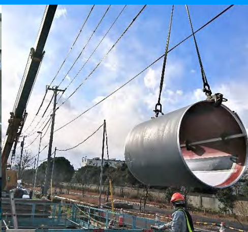
大口径管路の更新工事
