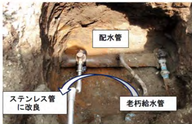
■道路内老朽給水管 改良状況
