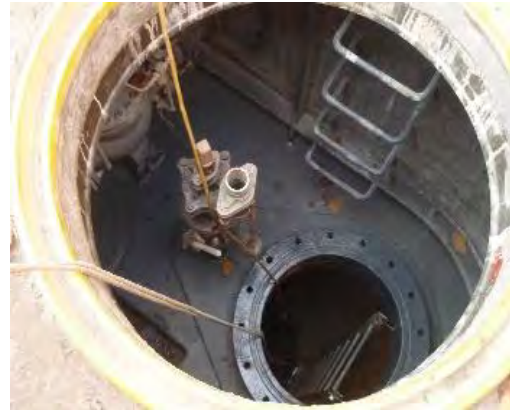
災害用地下給水タンクの点検
