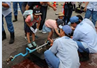
イベントでの水道管修理体験
