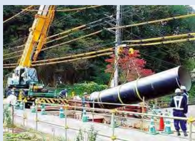
水道管の更新・耐震化工事
