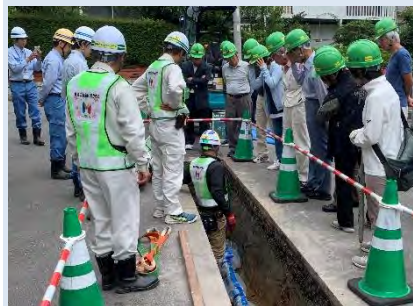
工事現場見学会
