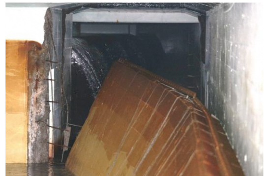
写真 施設の健全性が確認できず 長年の水圧で破損した 浄水場内部の構造物
