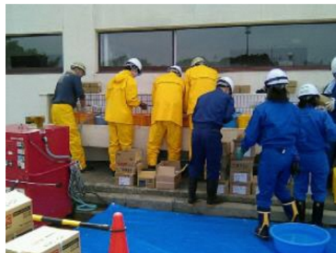
写真 浄水場事故発生後の復旧工事の
