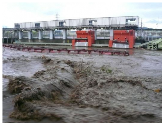
写真 台風による増水・水質悪化の状況 (飯泉取水管理事務所)
